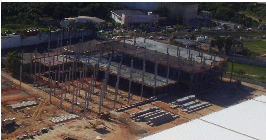
Figura 3 – Montagem da estrutura da obra.
